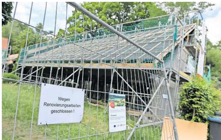
Das Glashaus wird seit Anfang Mai saniert.
