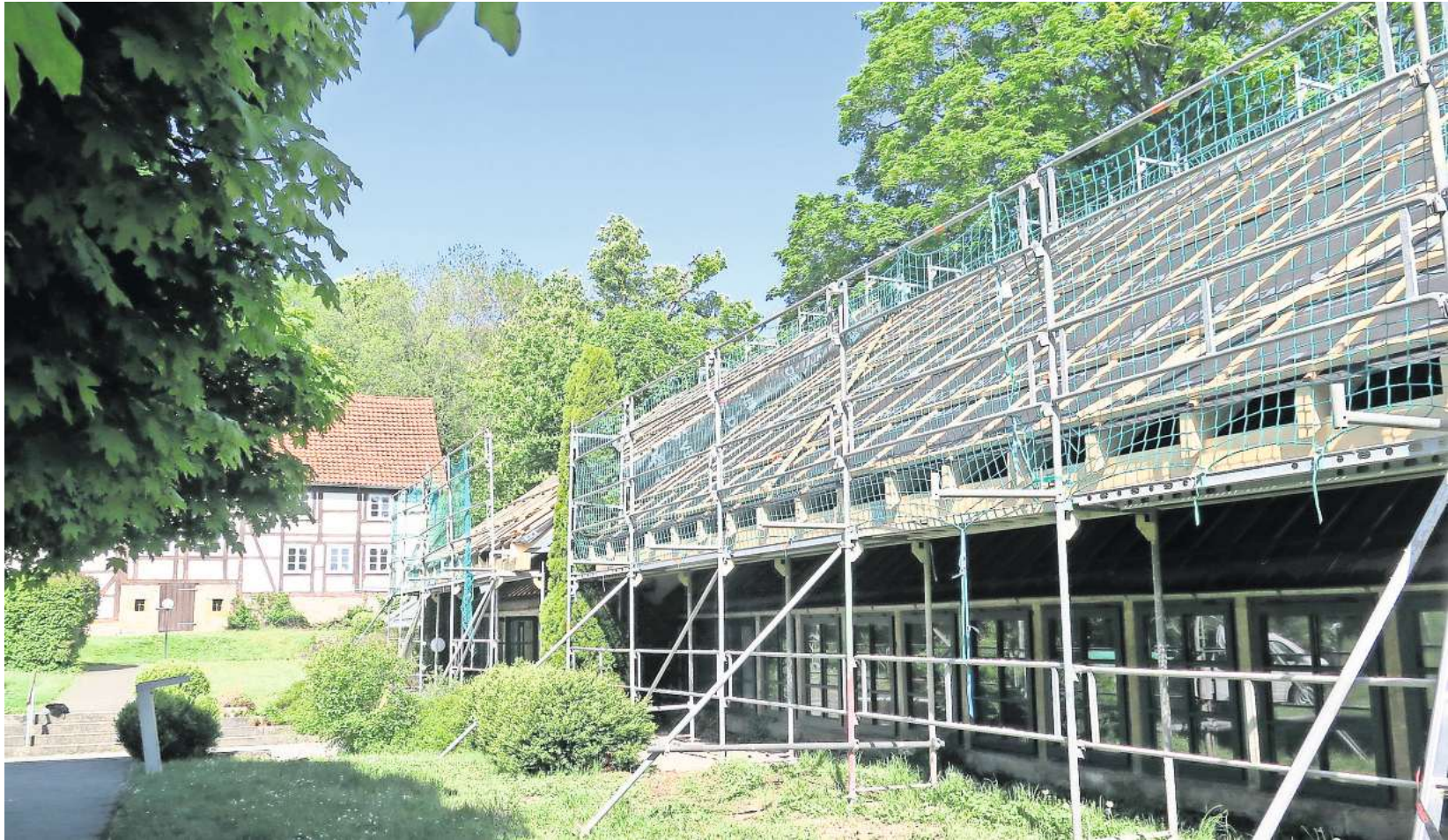
Die Sanierung des Derneburger Glashauses hat begonnen. Das Gebäude ist ingerüstet.
